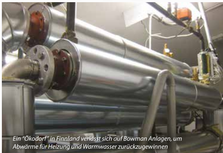
In Kanada versorgen Bowman Abgasanlagen innerhalb eines KWK-Systems Wärme für eine entfernte "netzferne" Gemeinde
