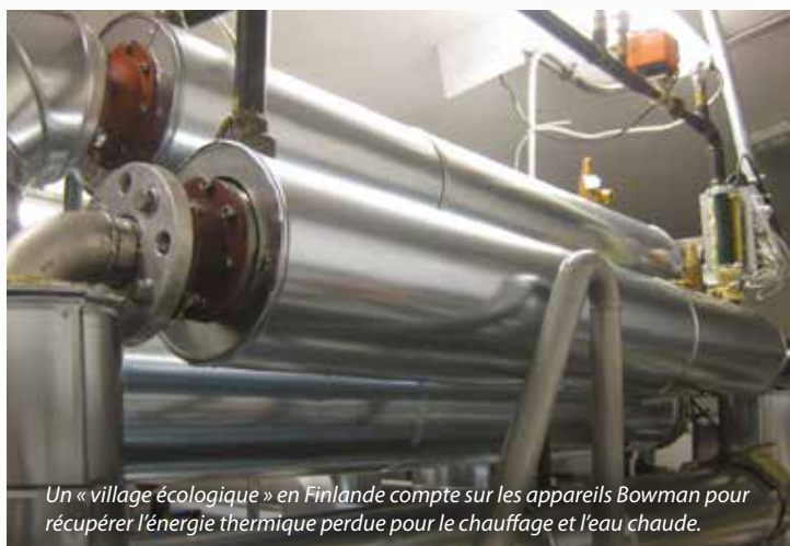
Au Canada, les appareils d'émission de gaz d'échappement Bowman utilisés au sein d'un système Cogen, fournissent de la chaleur à une communauté « hors réseau » éloignée.
