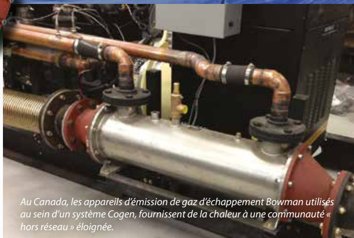
Les appareils de gaz d'échappement Bowman sont installés dans le système de cogénération de la station de recherche Halley VI du British Arctic Survey.
